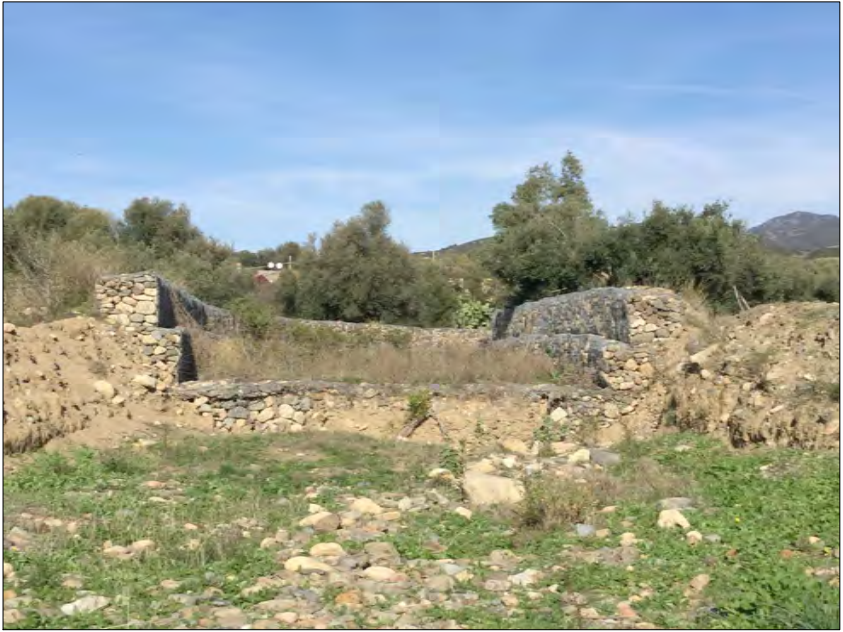
Foto 7 - Fine canale in gabbioni esistente
