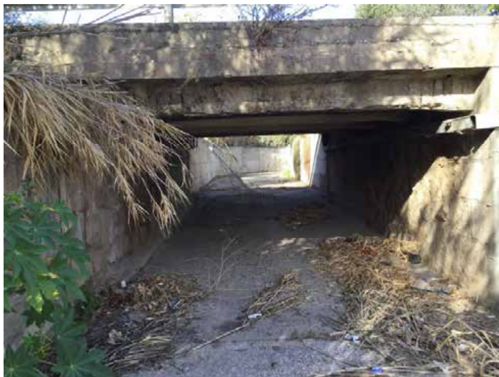
Figura 22 - Canale in c.a. - tratto attraversato da ponte sulla S.P. 1 (sez. 8-7.8)
