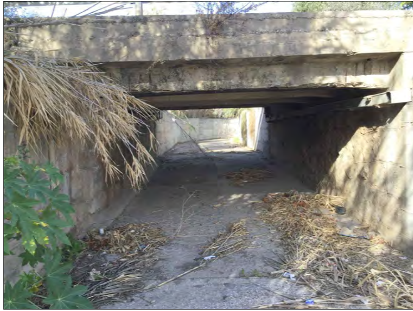
Foto 4 - Canale in cls, ponte sulla S.P. n.1
