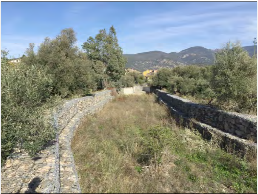
Foto 6 - Fine canale in cls e inizio tratto canale in gabbioni esistente
